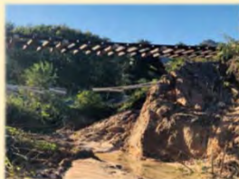
三陸鉄道 道床の流失
